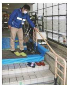
階段の手すり設置
