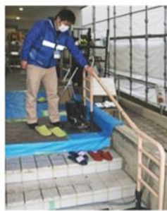
階段の手すり設置
