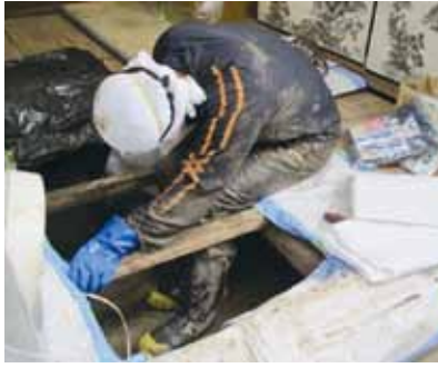
床下の泥出し作業の様子
